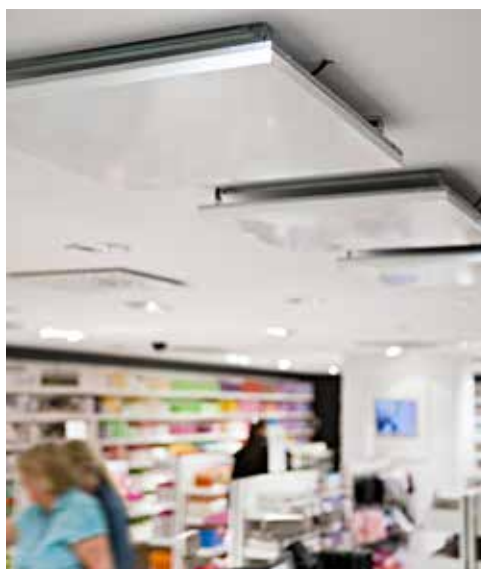
Takmontering beskytter Thermocassette mot skader.
