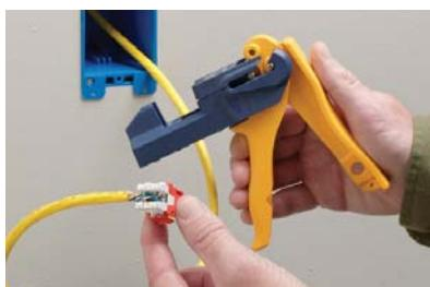
7. Utløs håndtaket og fjern kontakten fra JackRapid verktøyet. Inspiser visuelt at koblingen er korrekt.
