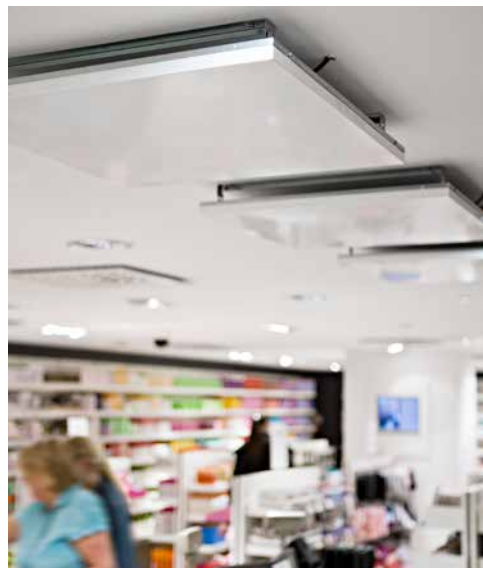
Takmontering beskytter Thermocassette mot skader.
