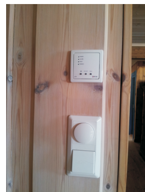
ICAS Brann-detektor: 500-IDx (x=O, I, T) O: Optisk, I: Ionisk, T: Termisk Sirene integrert: 85db/3m
