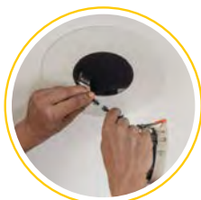
5. Elektrisk tilkobling og installasjon av den nye innfelte downlighten.
