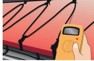
6. Zainstalować przewód(y) na dachu, w rynnach i rurach spustowych. Ponownie sprawdzić i porównać oporność izolacji.
