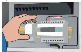
9. Installera termostaten/styrenheten och anslut kablarna till kopplingsdosor och elskåp.
