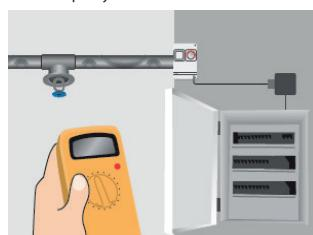
8. Znovu zkontrolujte izolační odpor. Připojte kabely ke spojovacím krabičkám a do rozvaděče.
