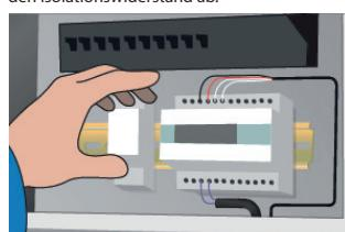
9. Installieren Sie das Thermostat/den Regler und verbinden Sie die Leitungen mit den Anschlussdosen und der Schalttafel.
