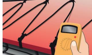
6. Installeer de kabel(s) op het dak, in gotten en in afvoerpijpen. Meet de isolatie weerstand nogmaals en vergelijk deze.
