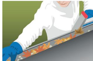
1. Bereiten Sie den Einbauort sorgfältig vor und entfernen Sie scharfe Gegenstände, Laub und Schmutz. Überprüfen Sie die Schalttafel und bereiten Sie diese vor.
