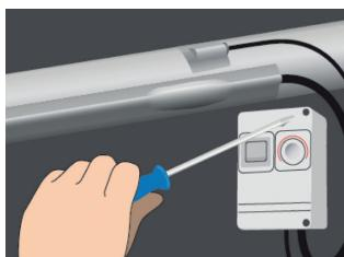
7. 用铝带将传感器与顶端固定在管道上方并盖住。延长冷接线/冷线，让接头保持干燥。将接线盒安装在管道上或其附近，然后将温控器安装在管道上或其附近（取决于温控器）。
