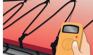
6. Installere kabelen/kablene på taket, i takrenner og fallror. Kontroller og sammenlign isolasjonsmotstanden på nytt.
