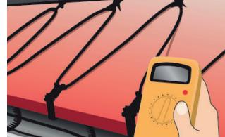
6. Kable vgradite na strehi, v žlebove in odtočne cevi. Še enkrat preverite in primerjajte izolacijsko upornost.
