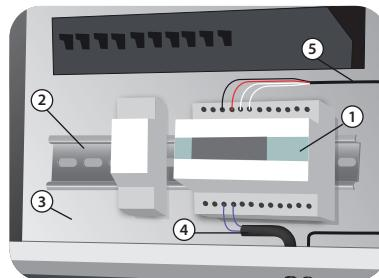
1 - Kontrol cihazı; 2 - DIN rayı; 3 - Elektrik panosu; 4 - Soğuk uç bağlantısı; 5 - Sensör bağlantısı
