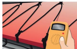
6. Монтирайте кабелите на покрива, в улците и водосточните тръби. Проверете отново и сравнете изолационното съпротивление.
