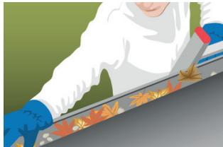
1. Förbered installationsplatsen ordentligt genom att ta bort vassa föremål, löv och lera. Kontrollera och förbered elskåpe.
