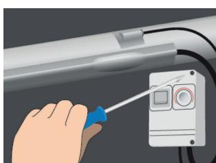
7. Ataşați și acoperiți senzorul și vârful pe conductă cu bandă de aluminiu. Prelungiți racordurile/cablurile reci și mențineți conexiunile uscate. Montați cutia de legături pe conductă sau în apropiere sa și instalați termostatul pe conductă sau în apropierea sa (în funcție de termostat).
