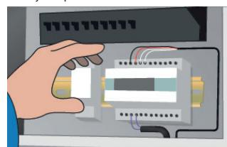
9. V priključne omarice in stikalno ploščo vgradite termostat/regulator ter povežite kable.
