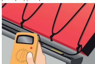
8. Verificați din nou și comparați rezistența izolației. Valoarea măsurată nu va fi mai mică de 50 MΩ.
