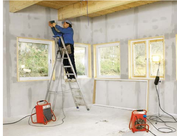
Tiger 3–9 kW (400V3N~) har et 230V uttak på baksiden for enkel tilkobling av for eksempel lys eller en lader for trådløst verktøy. Praktisk på byggeplasser!
